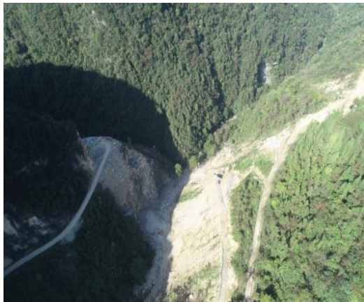
岩口河大桥横跨段（未施工）
