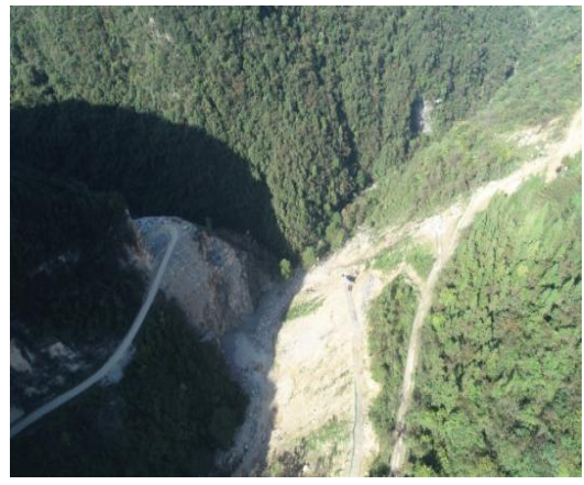
岩口河大桥横跨段（未施工）
