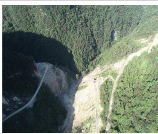
岩口河大桥横跨段（未施工）
