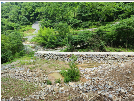
弃渣场挡土墙
