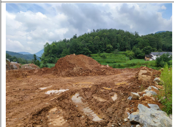
裸露区域临时苫盖
