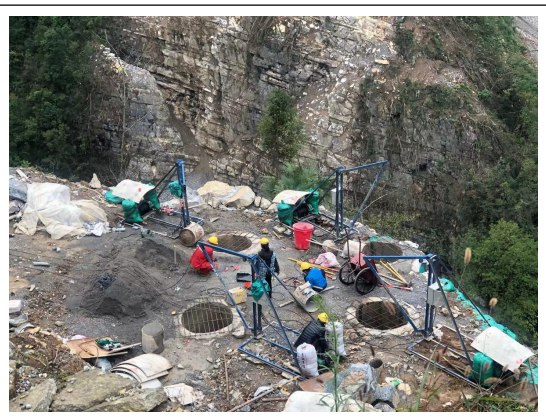
岩口河大桥施工（目前已停工）
