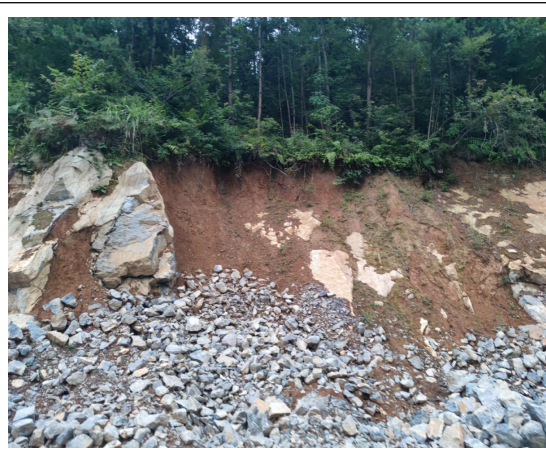
对边坡及时进行防护
