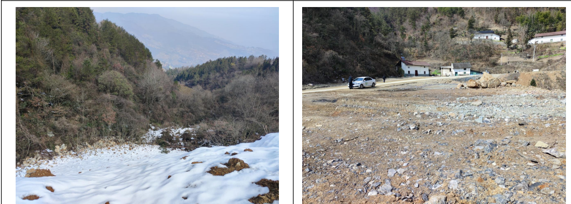
弃渣场边坡及时进行防护
