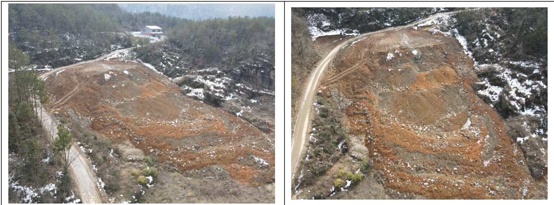
k21+920 弃渣场 (需及时进行植被恢复修建排水设施)
