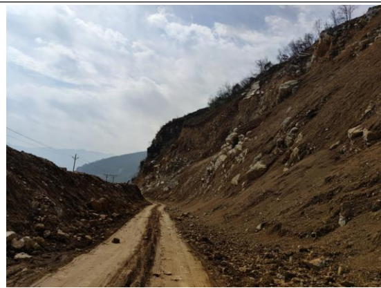
易流失区域及时进行防护
