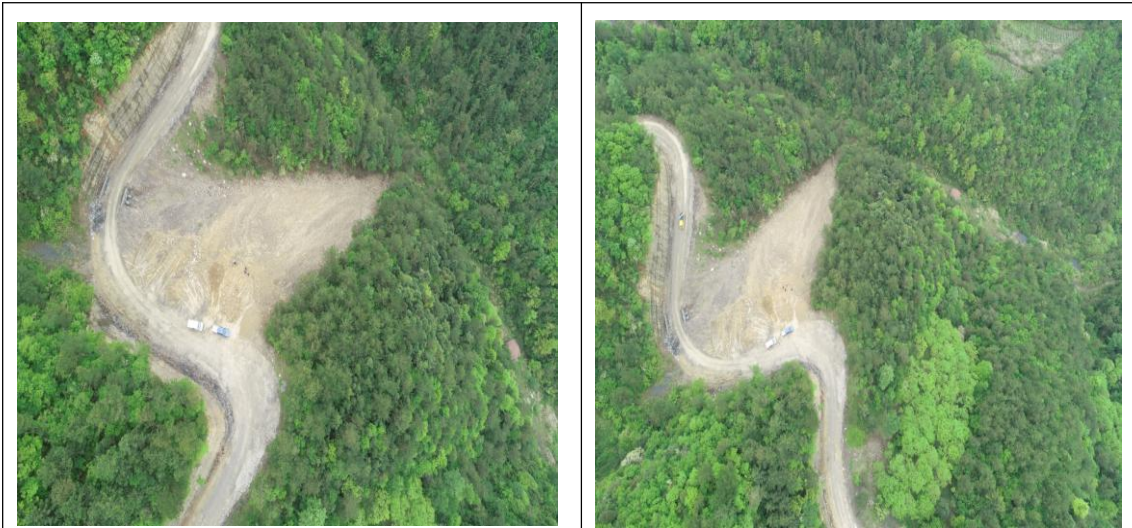
K10+154 (坡脚及时修建挡土墙, 对弃渣场进行植被恢复)
