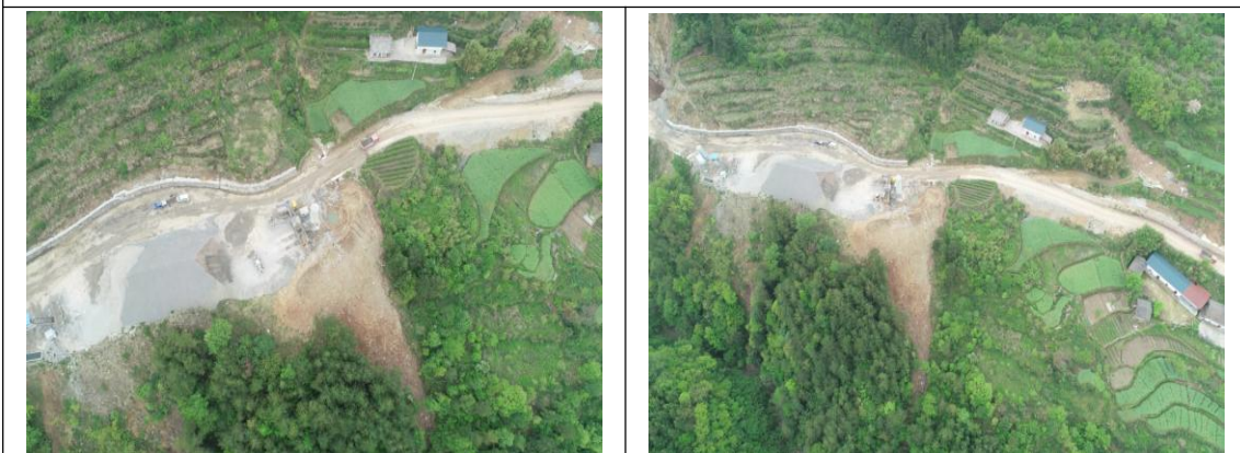
K17+900 (下边坡及时修建挡土墙)
