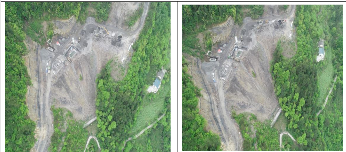
K12+438 (对弃渣坡面及时进行植被恢复)
