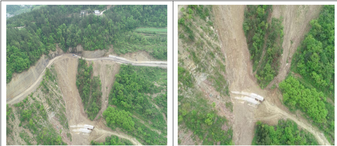
K14+700 (及时对弃渣场进行植被恢复)
