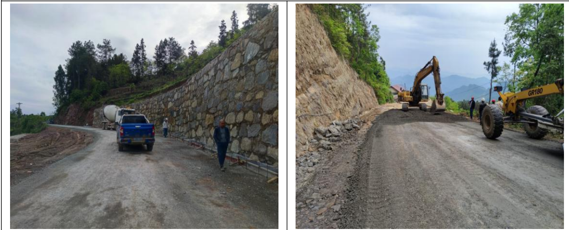
路基垫层摊铺
