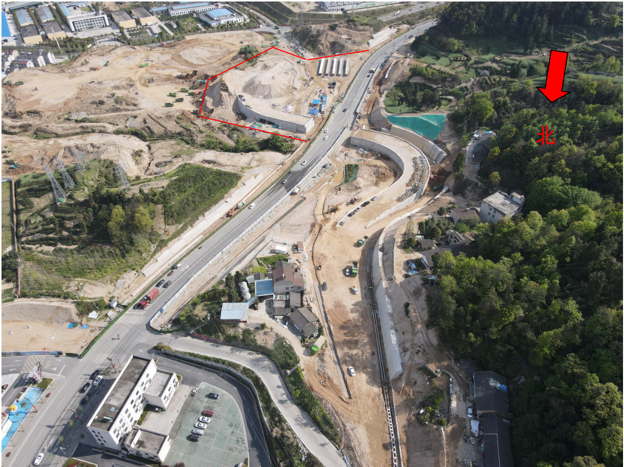
图 2-6 一期（芝茅路与明珠大道互通）注：红色为边界线，左侧为其他工程施工场地
