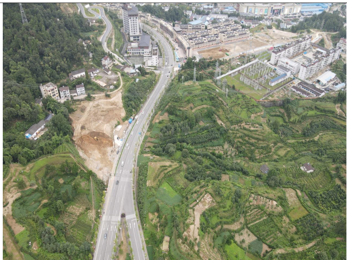
本项目一期 8 月航拍（芝茅路互通段）
