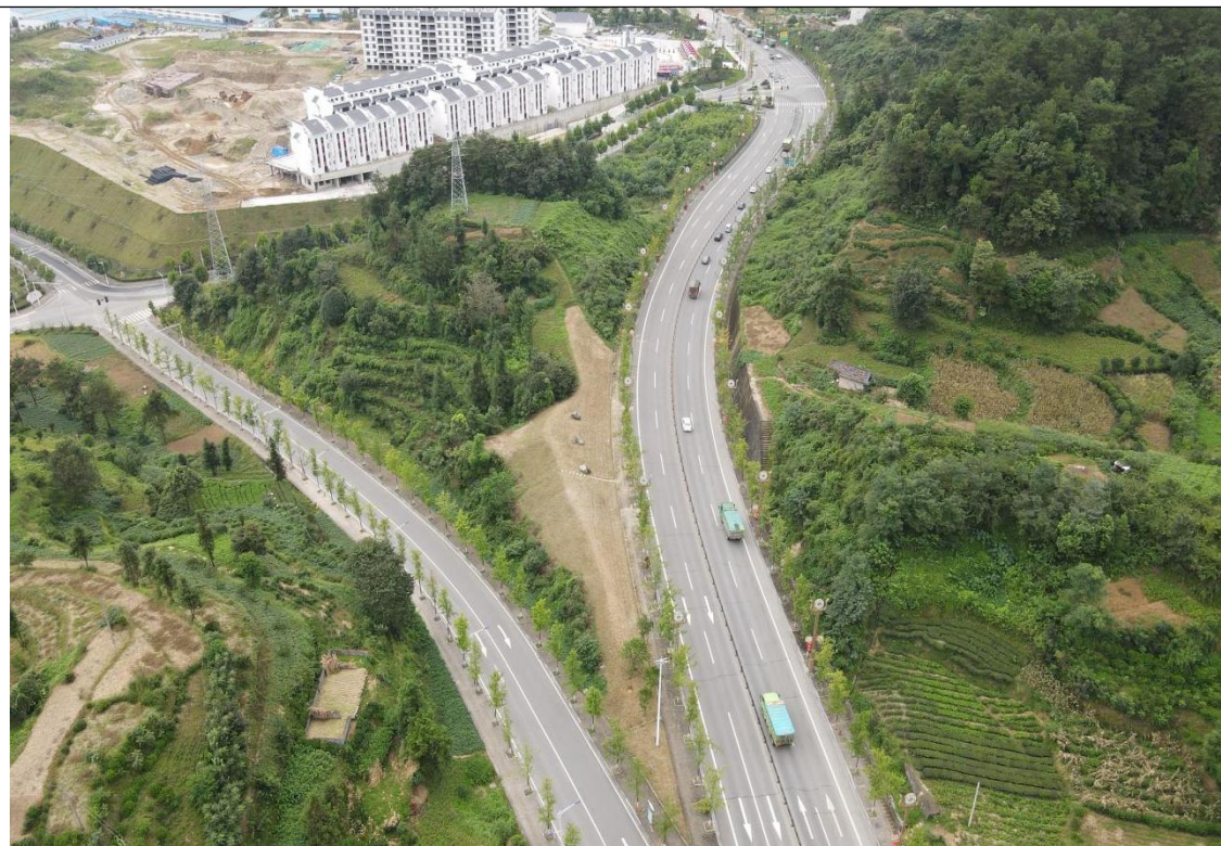
本项目二期 8 月航拍（二圣路、楚天路互通段）
