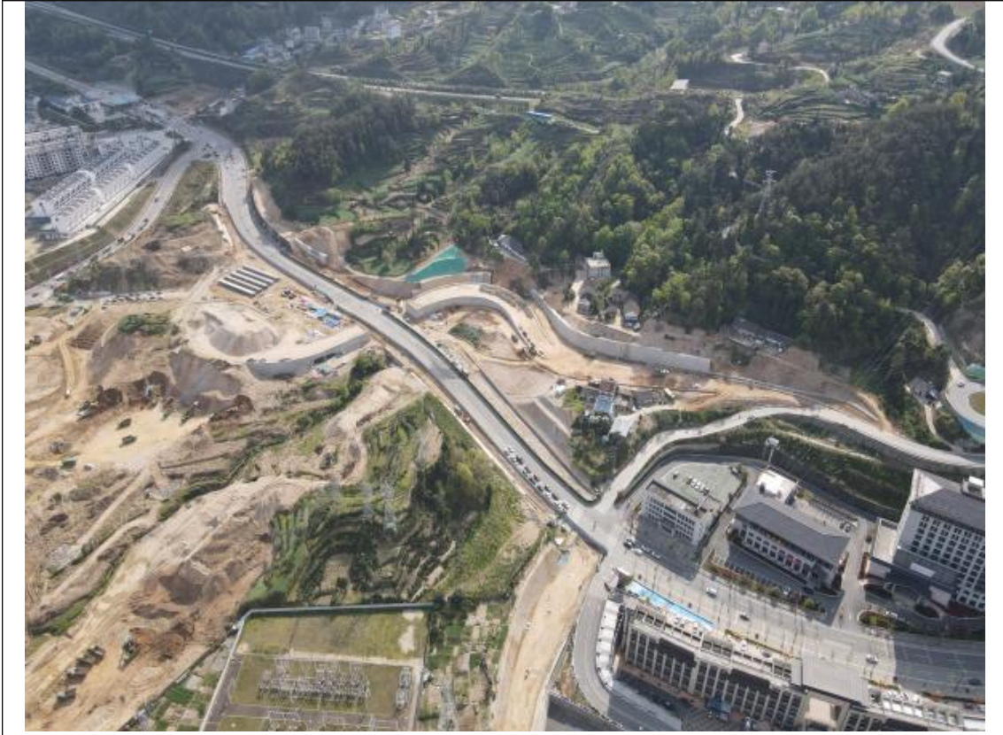
项目区航拍全貌
