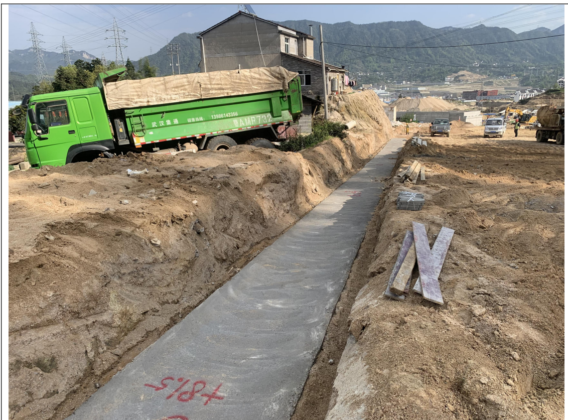
A型边沟底板浇筑
