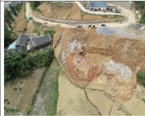
K20+750 弃渣场 (完善建挡土墙, 及时进行植被恢复)
