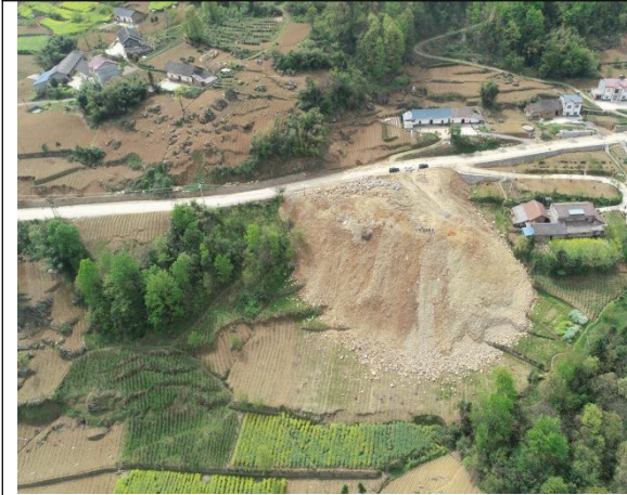
K4+980 弃渣场 (挡土墙修建中, 及时进行植被恢复)
