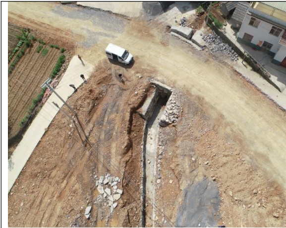
K17+300 弃渣场 (进行植被恢复)
