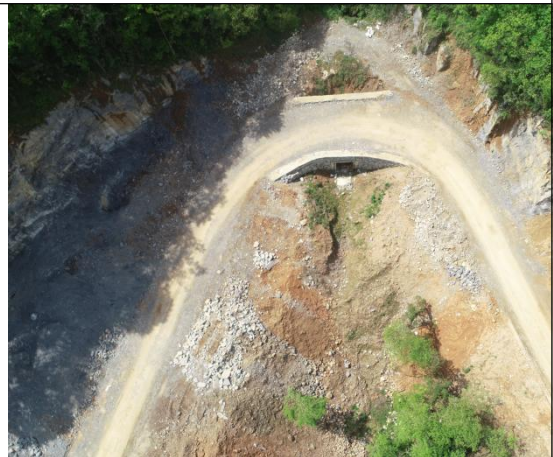
K14+140 弃渣场 (完善挡土墙及排水沟修建)
