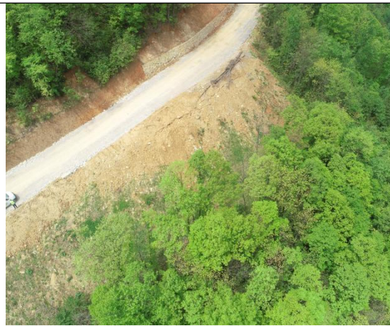
K22+690 弃渣场 (进行植被恢复)
