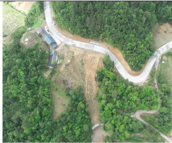
K19+200 弃渣场 (进行植被恢复)
