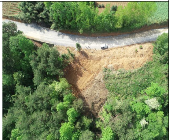
K11+050 弃渣场 (及时进行挡土墙砌筑, 进行植被恢复)
