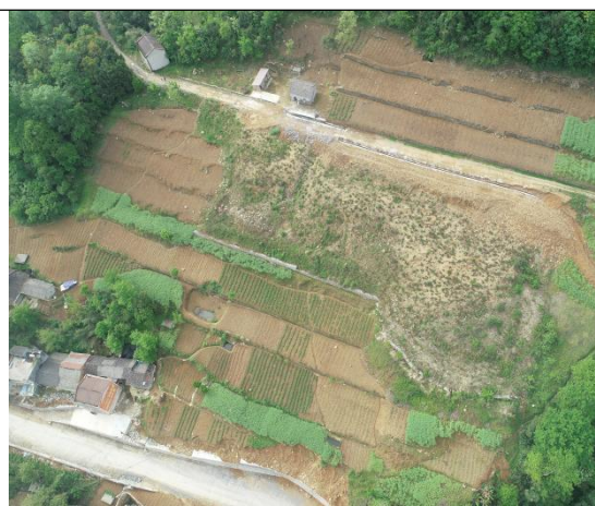
K1+930 弃渣场 (及时进行整治, 并进行植被恢复)
