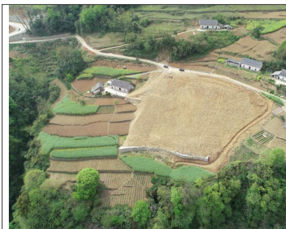
K1+640 弃渣场 (需及时进行复垦)
