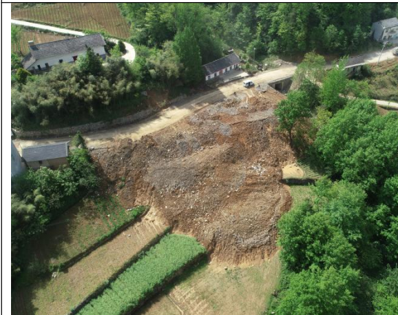
K11+700 弃渣场 (挡土墙砌筑中, 进行植被恢复)
