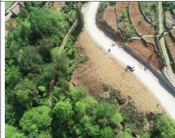
K9+460 弃渣场 (及时进行挡土墙砌筑, 进行植被恢复)
