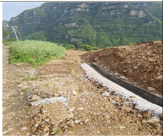
混凝土排水沟
