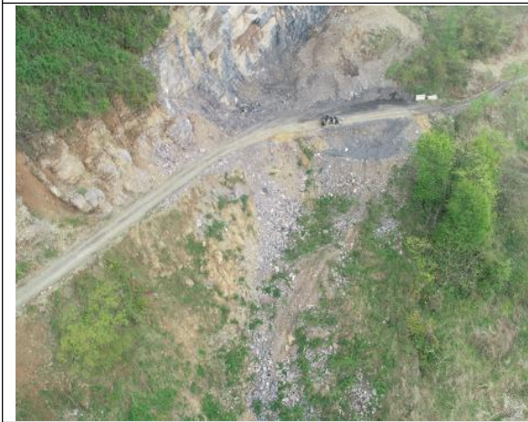
K27+925 弃渣场 (几乎未弃渣, 及时进行植被恢复)
