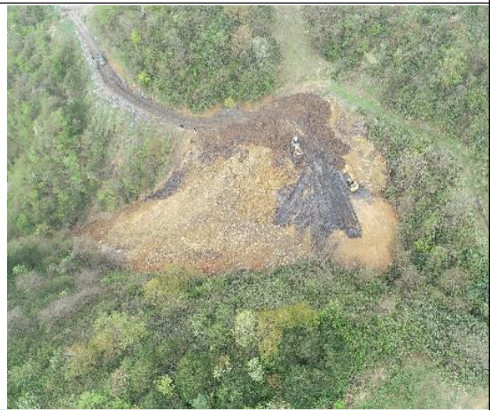
K28+925 弃渣场 (正在进行排水施工, 及时进行植被恢复)
