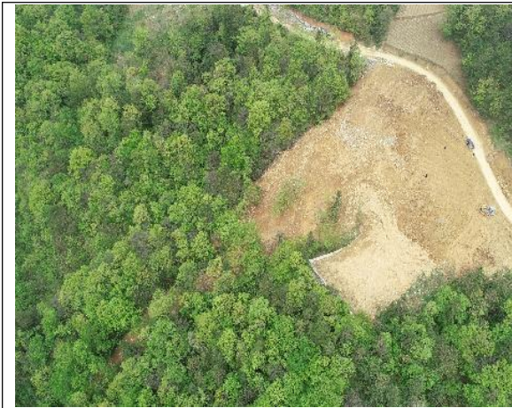
K24+940 弃渣场 (需及时进行植被恢复)
