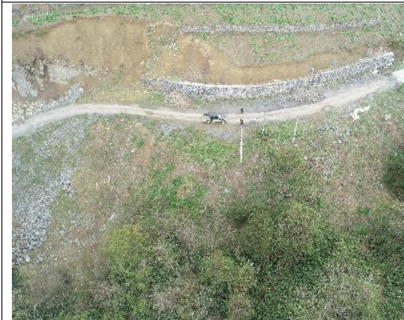
K30+145 弃渣场 (几乎未弃渣, 及时进行植被恢复)
