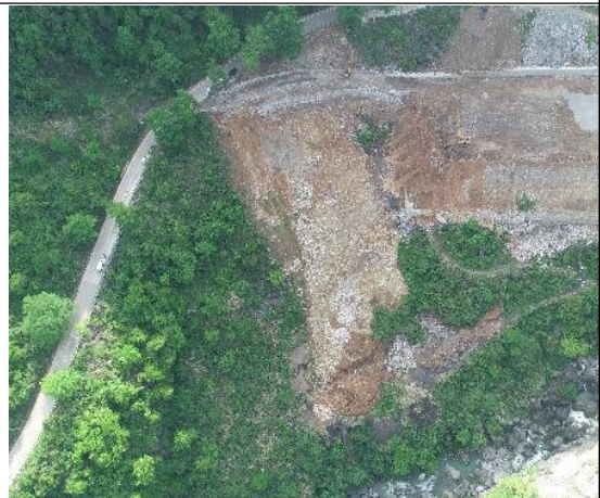
老林河弃渣场 (正在进行排水施工, 及时进行植被恢复)
