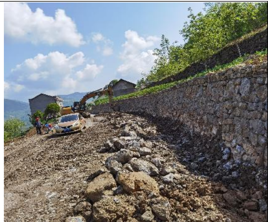
道路临时排水沟施工
