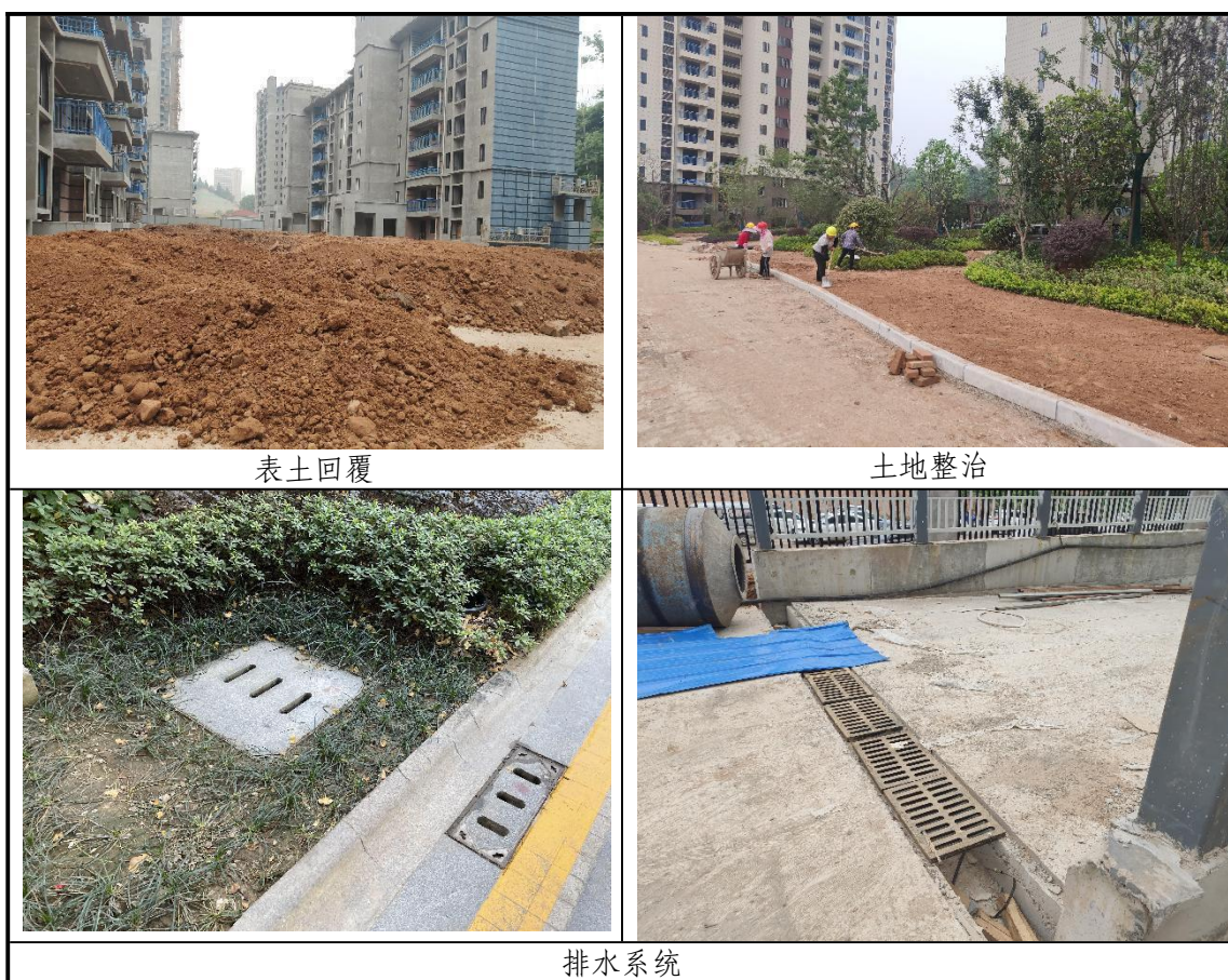
图 4-1 现场实施的工程措施
