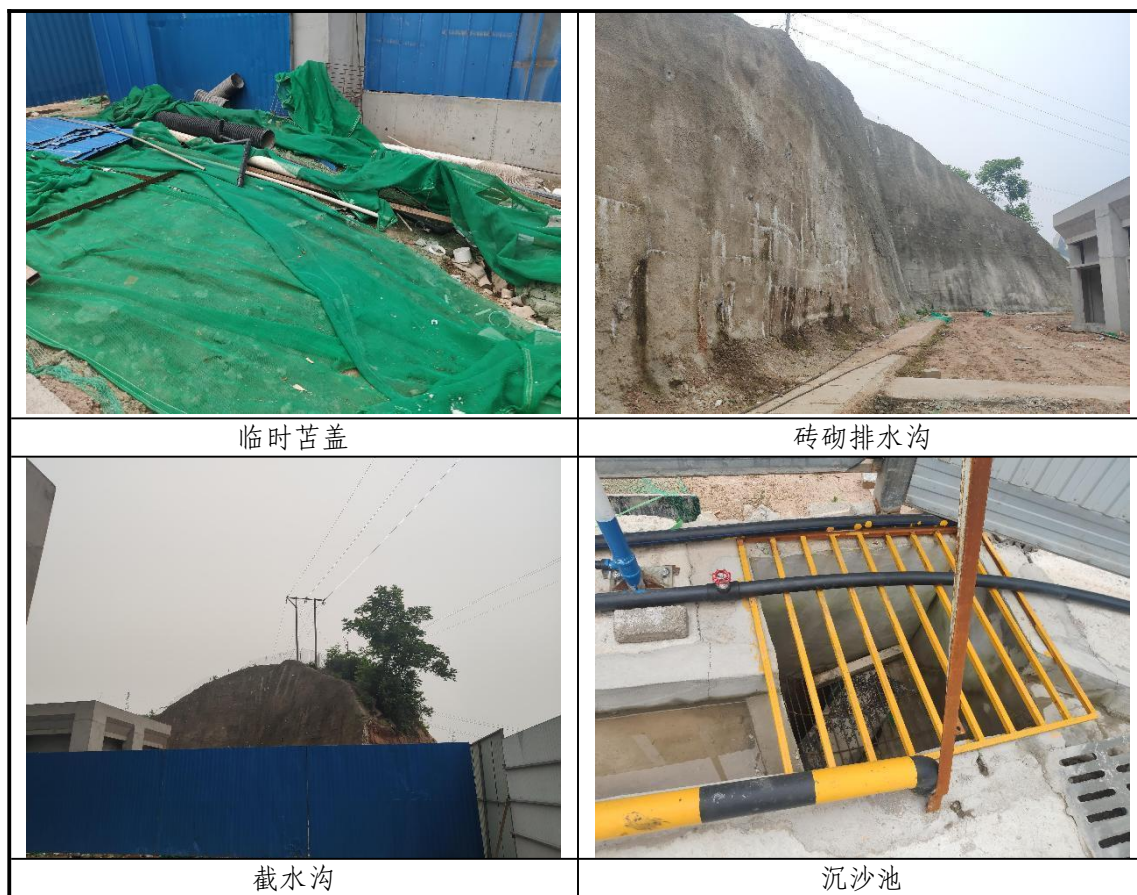
图 4-3 现场实施的临时措施
