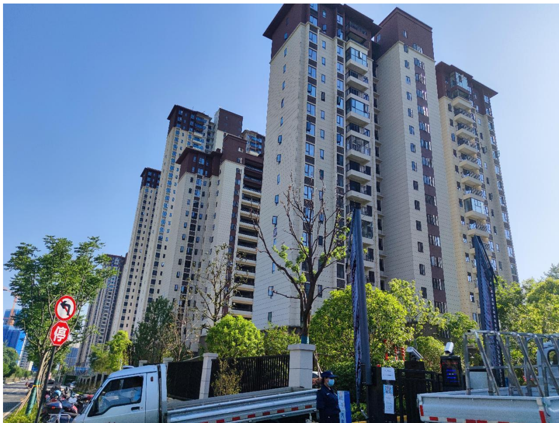
完工后建筑物
