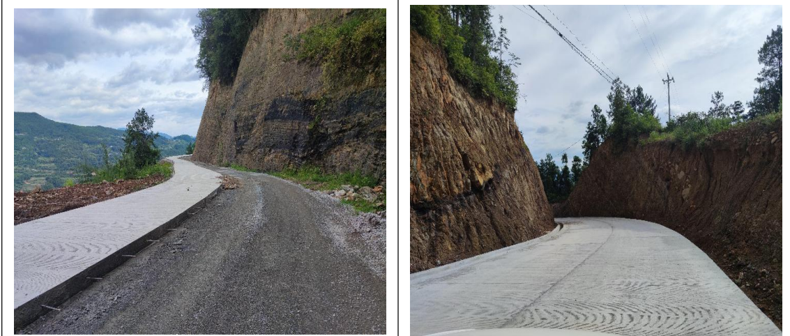
路基混凝土摊铺
