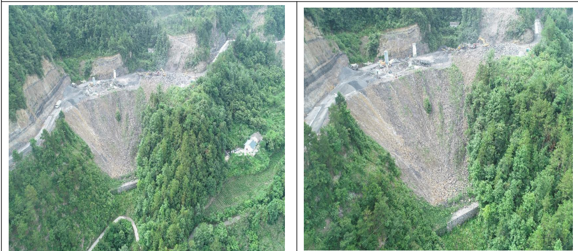
K12+438 (对弃渣坡面及时进行植被恢复)
