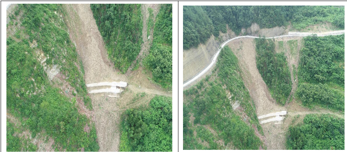
K14+700 (及时对弃渣场进行植被恢复)
