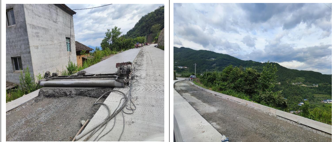
路基混凝土摊铺
