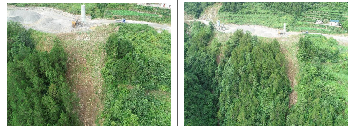
K17+900 (下边坡及时修建挡土墙)
