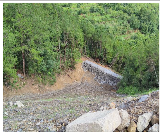
K10+154 弃渣场挡土墙
