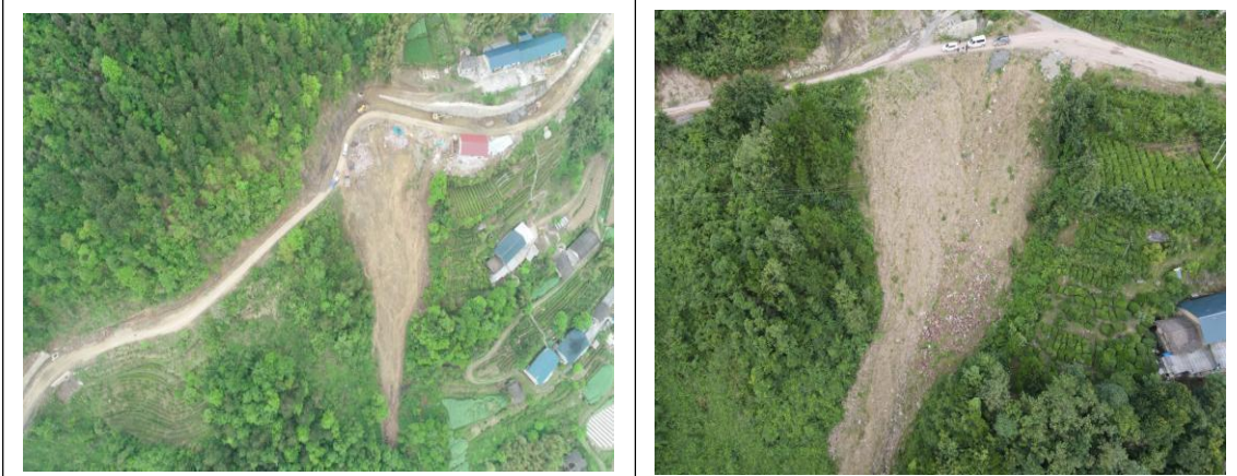
K16+656 (需及时进行挡土墙及排水沟修建)
