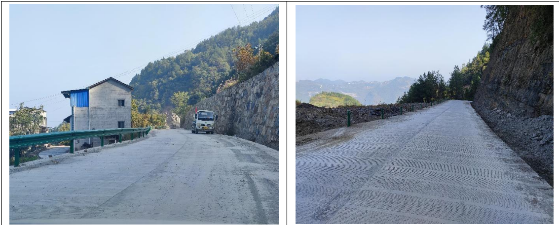
路面已完成全线混凝土摊铺
