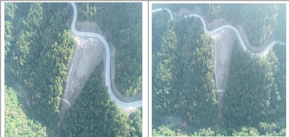
K10+154 (堆渣渣面及时完善植物措施)
