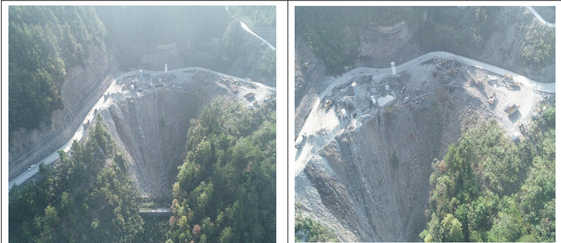
K12+438 (对弃渣坡面及时进行植被恢复)
