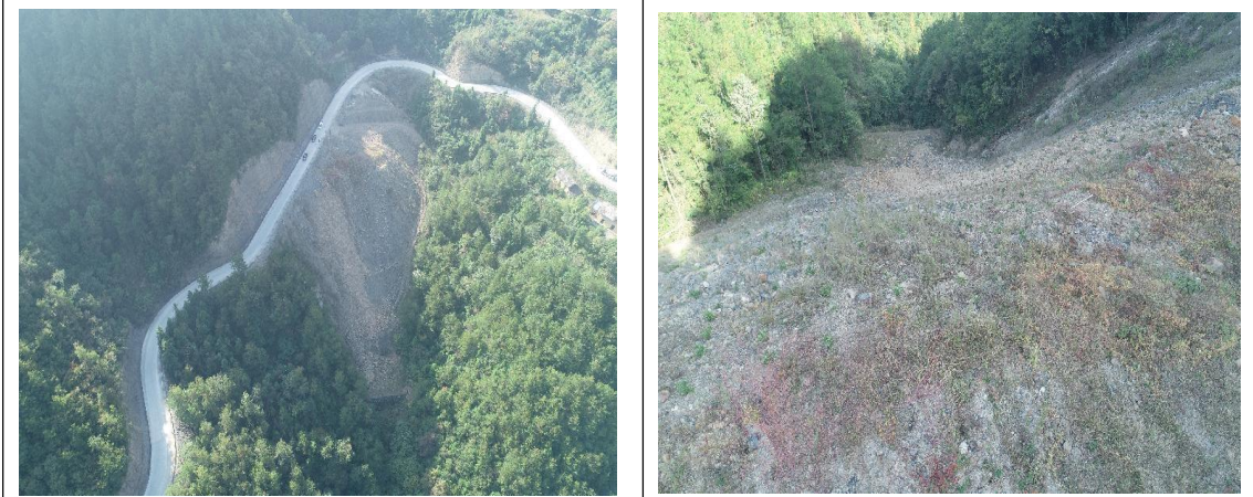
K10+480 (堆渣渣面及时恢复植物措施, 养护已种植植被)
