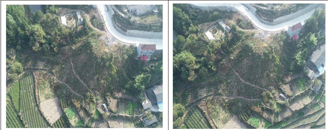
K20+790 (下边坡及时修建挡土墙)
