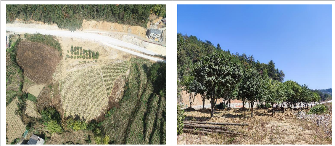
K21+580 弃渣场（需及时进行修建截水沟）
