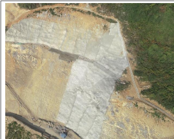
边坡整治+截水沟
