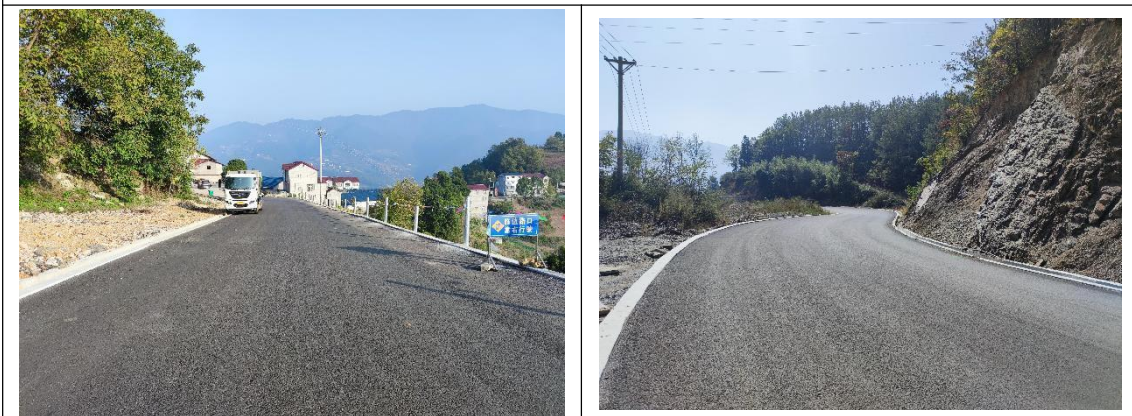
路基现状（已完成沥青摊铺路段）
