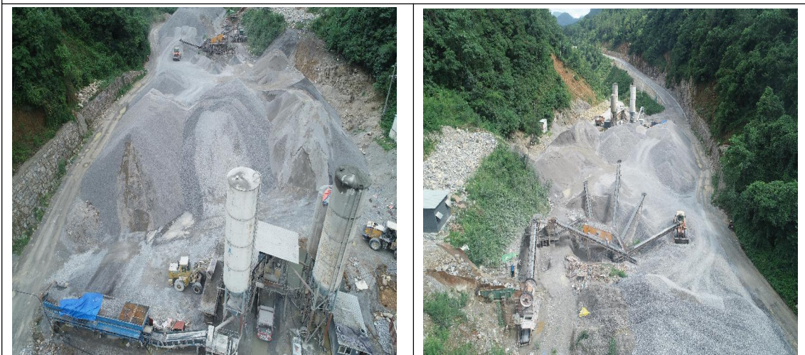
K20+050 弃渣场（施工完毕后及时实施植物措施）
