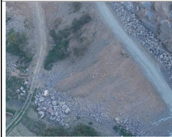
K27+925 弃渣场 (几乎未弃渣, 建议进行植被恢复)
