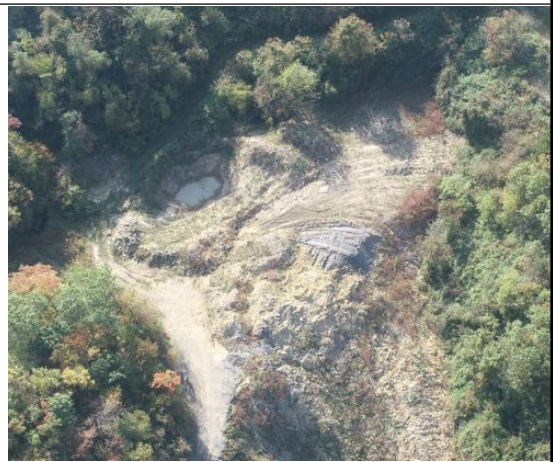
K28+925 弃渣场 (完善挡土墙和排水施工, 进行植被恢复)
