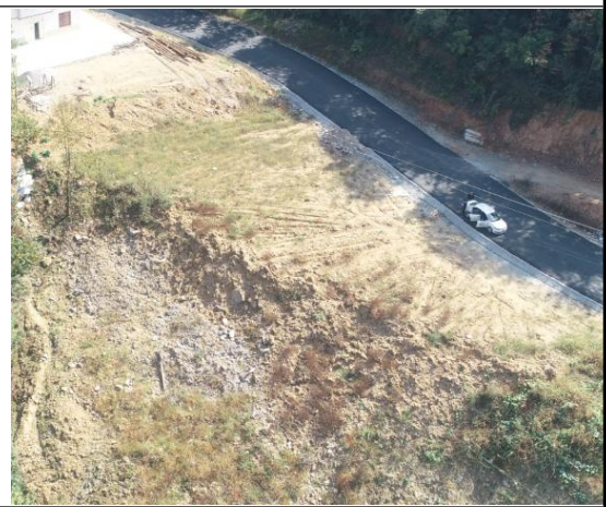
K19+200 弃渣场 (建议增加挡排措施, 植被恢复)
