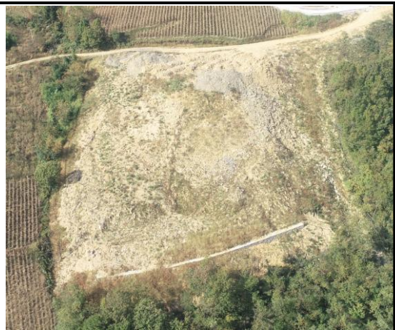
K25+940 弃渣场 (建议分级放坡、排挡施工、植被恢复)
