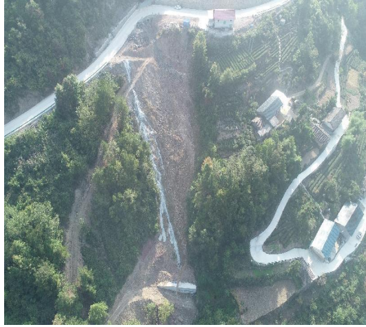
K16+565 (对排水涵洞进行截流, 避免路基排水出口汇入弃渣场造成雨水冲刷)
