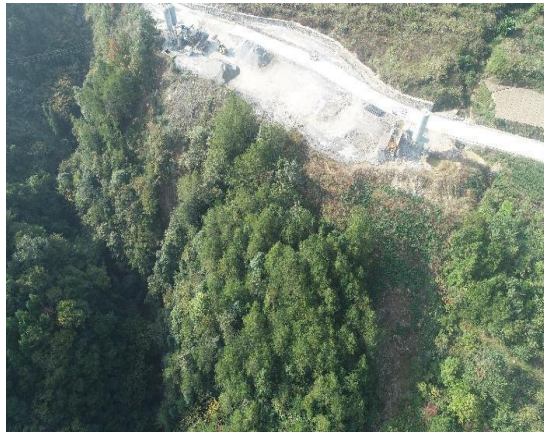
K17+900 (对涵洞出水口及时进行疏通, 保证出水口不侵蚀弃渣场坡脚)
