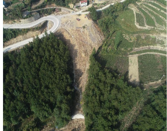
K19+520 (清理边坡碎石, 完善表土回覆措施, 对涵洞进行引流)
