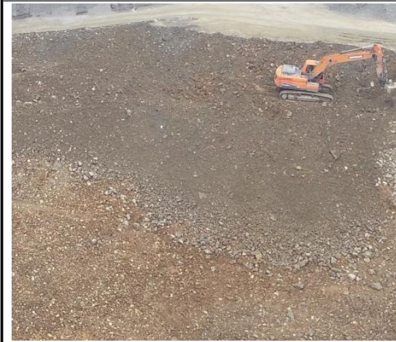
弃渣场场地平整
