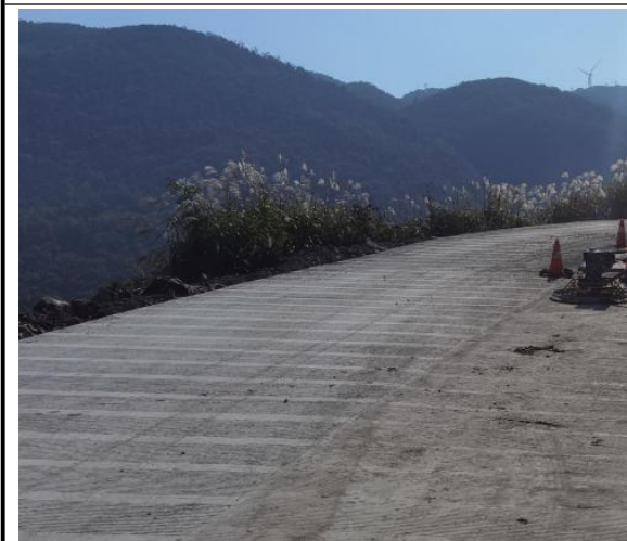
三标段混凝土道路
