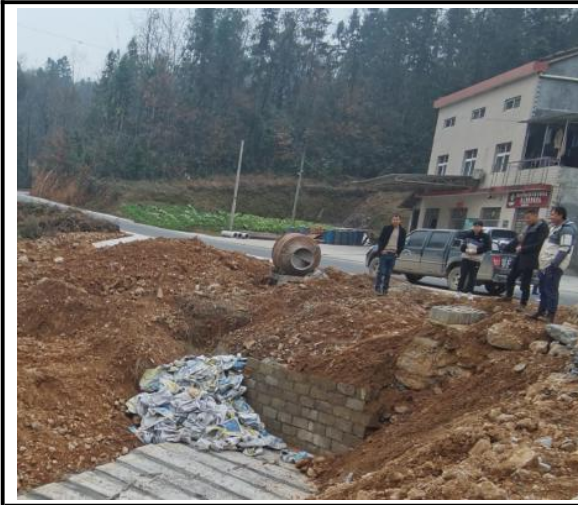
水保监测现场检查
