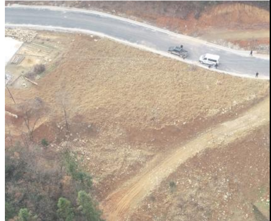
K19+200 弃渣场 (已场地平整, 建议复耕)
