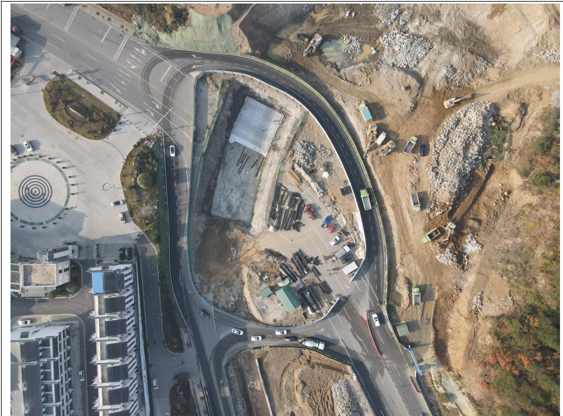
二圣路互通（下穿明珠大道地下隧道段）
