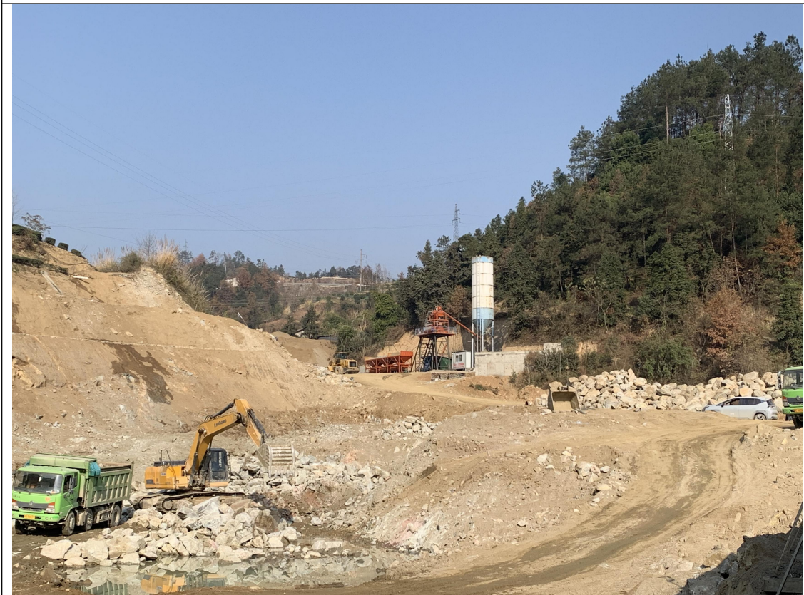
二圣路互通（2#施工生产作业区）
