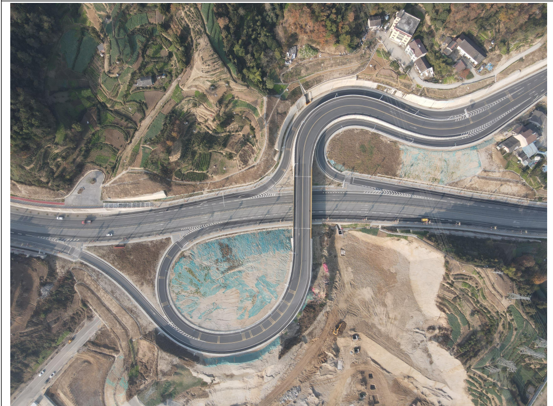
芝茅路互通（跨明珠大道桥梁工程区）
