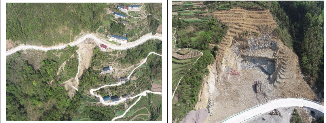
K16+565 (对排水涵洞进行截流, 避免路基排水出口汇入弃渣场造成雨水冲刷)
