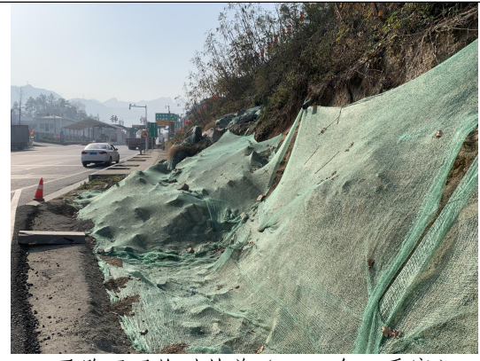
二圣路互通临时苫盖 (2023 年 1 季度)
