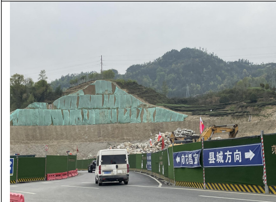
二圣路互通临时苫盖 (2023 年 1 季度)
