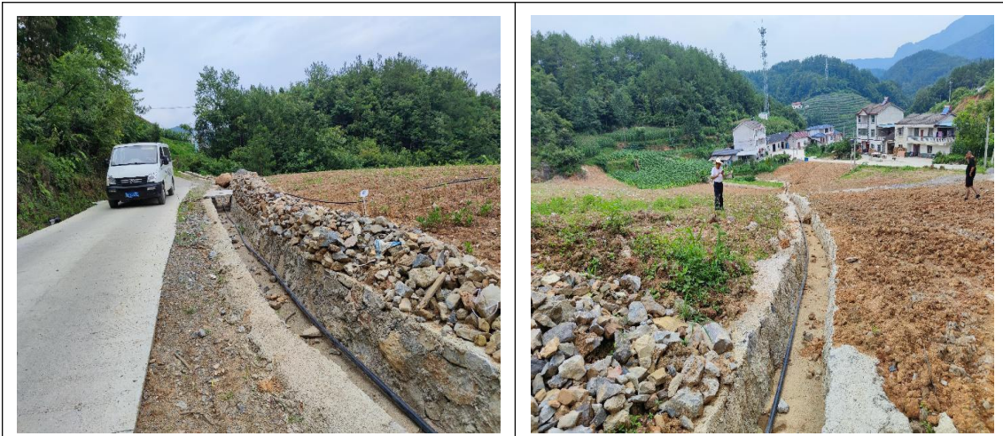
弃渣场截排水沟
