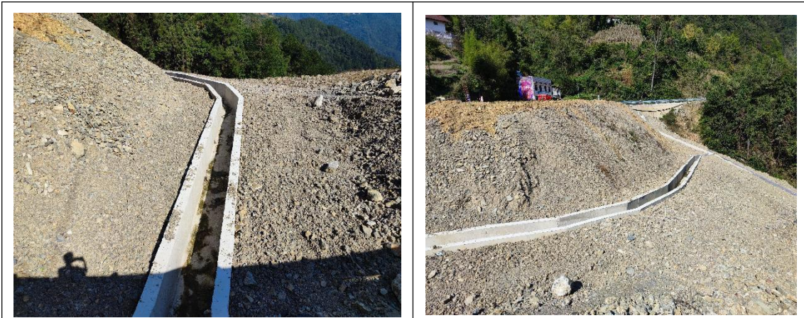
K10+140 弃渣场截排水沟
