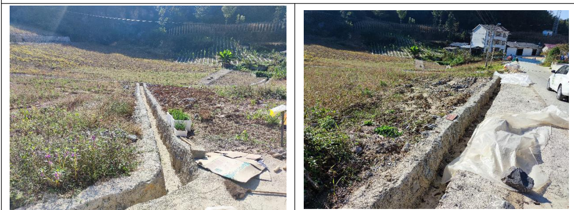
K21+920 弃渣场截排水沟
