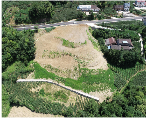
K4+980 弃渣场 (2023年2季度, 已进行土地整治, 复耕中)
