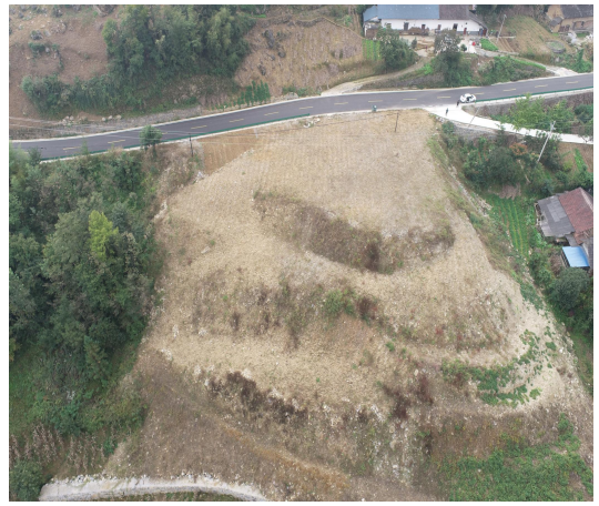
K4+980 弃渣场 (2023年3季度, 已进行土地整治, 复耕中)
