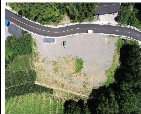
K11+700 弃渣场 (2023年2季度, 建议对坡面进行绿化)
