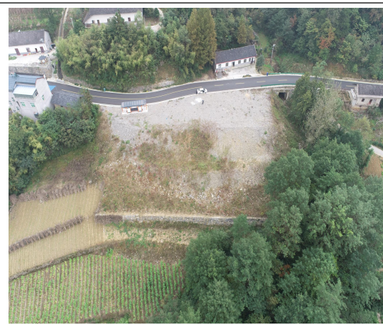
K11+700 弃渣场 (2023年3季度, 建议对坡面进行绿化)
