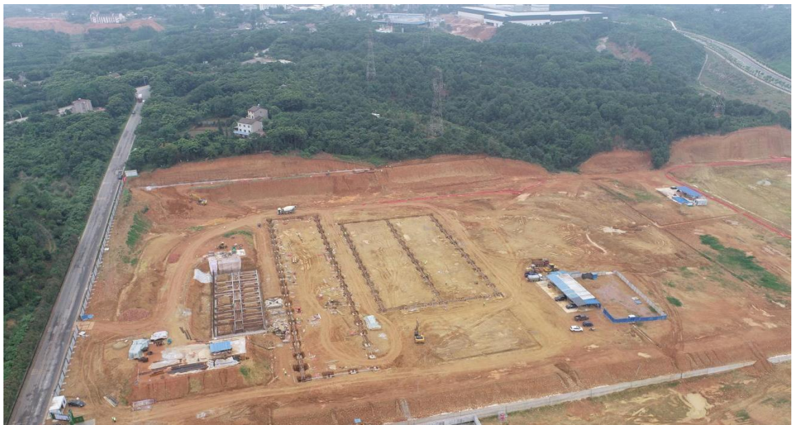
已建云保路（左侧）、建设中的石墨系列产品项目、高压走廊（上部）
