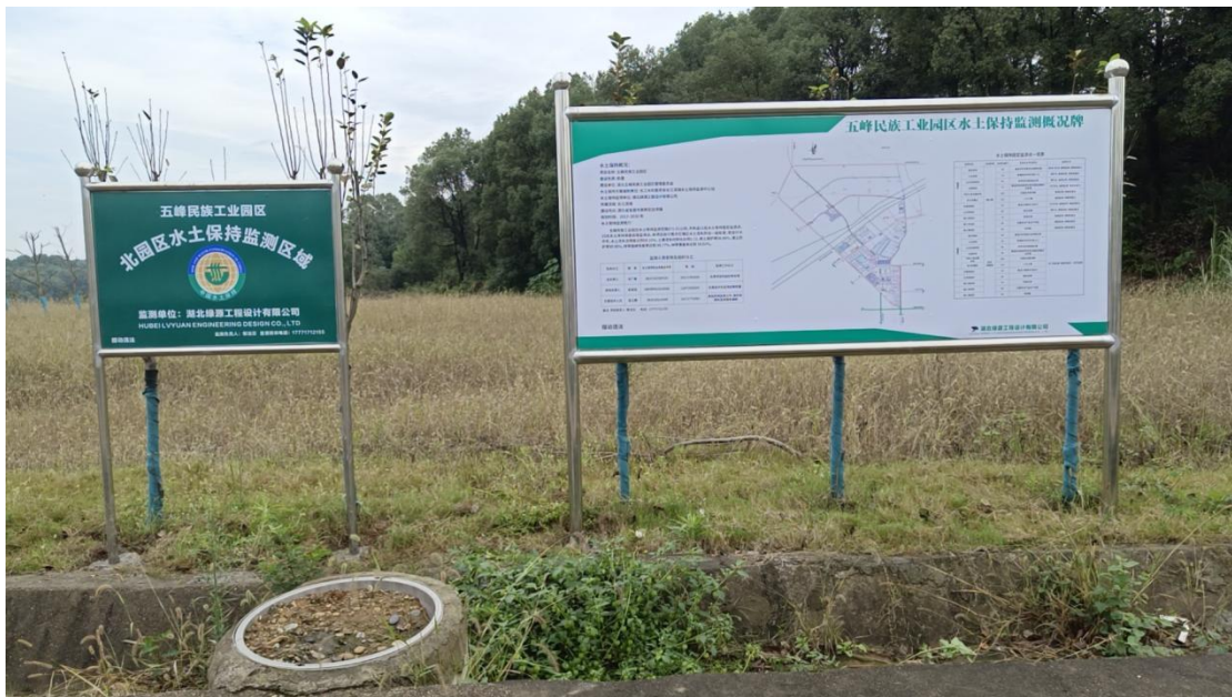
安装监测概况牌
