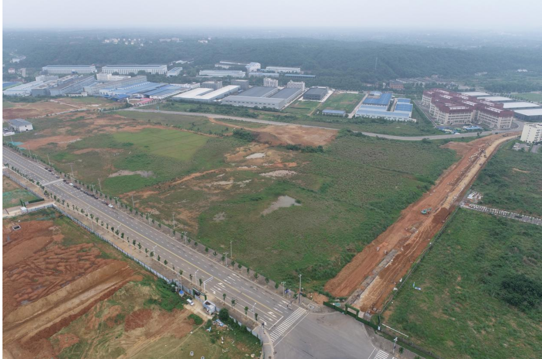
已建成紫云大道和建设中的利时路改扩建及新建停车场项目
