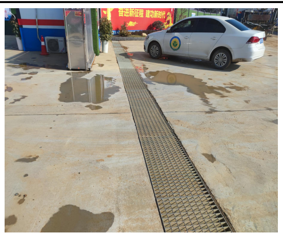
道路 K16+400 示范区 (2024 年 1 月)
