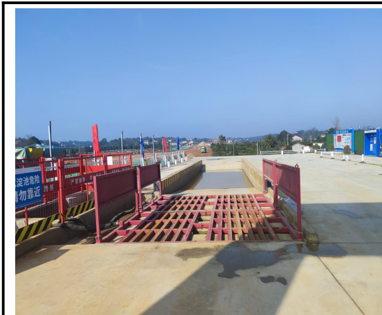
道路 K16+400 示范区 (2024 年 1 月)
