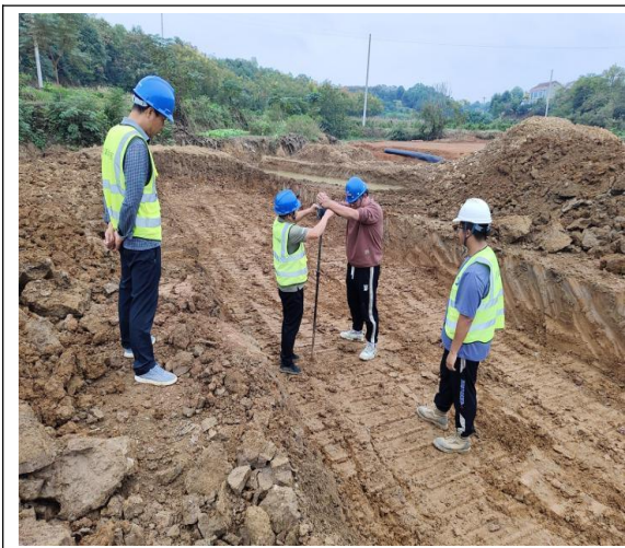
k15+240 排水箱涵沟槽承载力检测 (2023.09.29)
