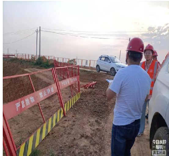
安全文明施工措施检查 (2023.10.23)
