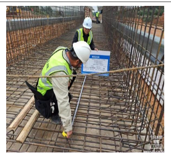
K17+646 排水箱涵钢筋 (2023.11.15)
