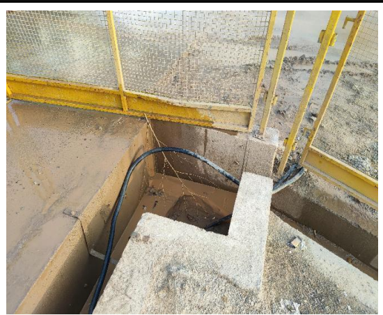
临时排水沟、沉沙池（2023年12月）
