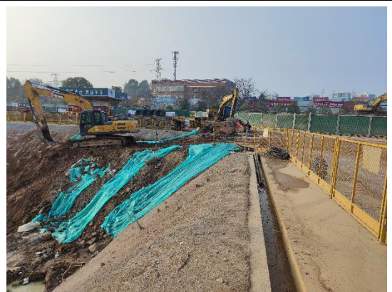
临时苫盖（2023年12月）
