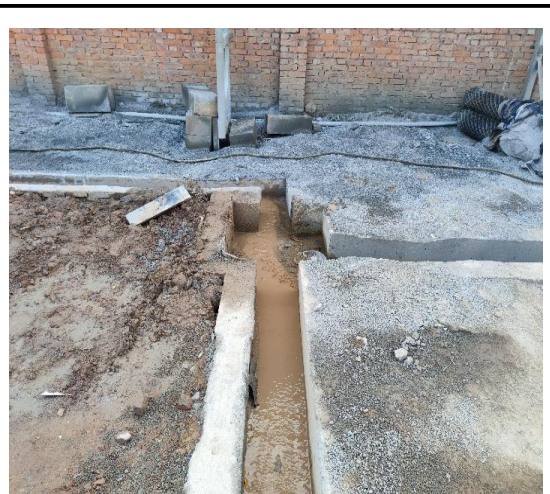
临时排水沟、沉沙池（2023年12月）
