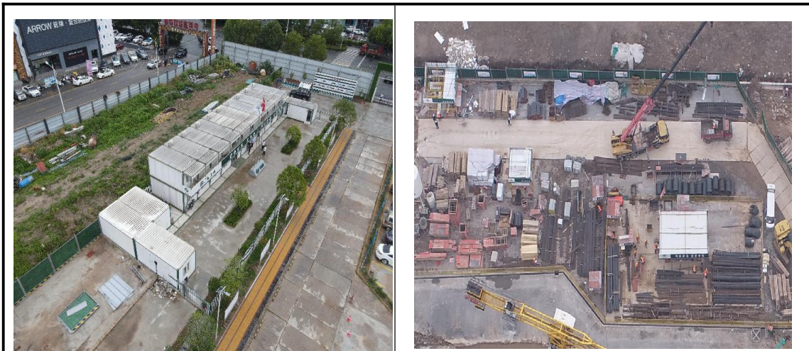
施工生产生活区（2023年12月）
