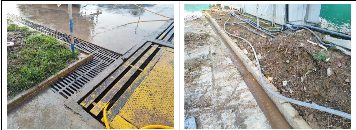
临时排水沟（2023年12月）
