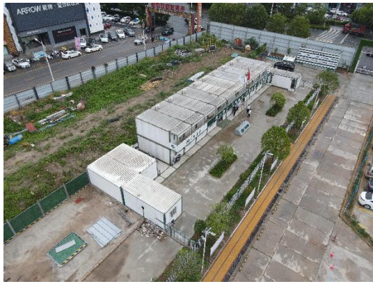
施工生产生活区
