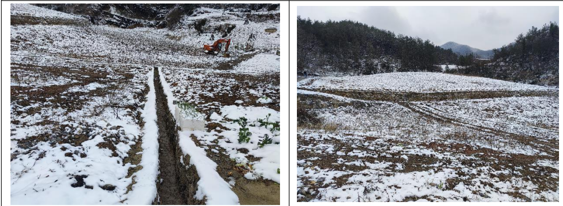
弃渣场绿化+排水沟
