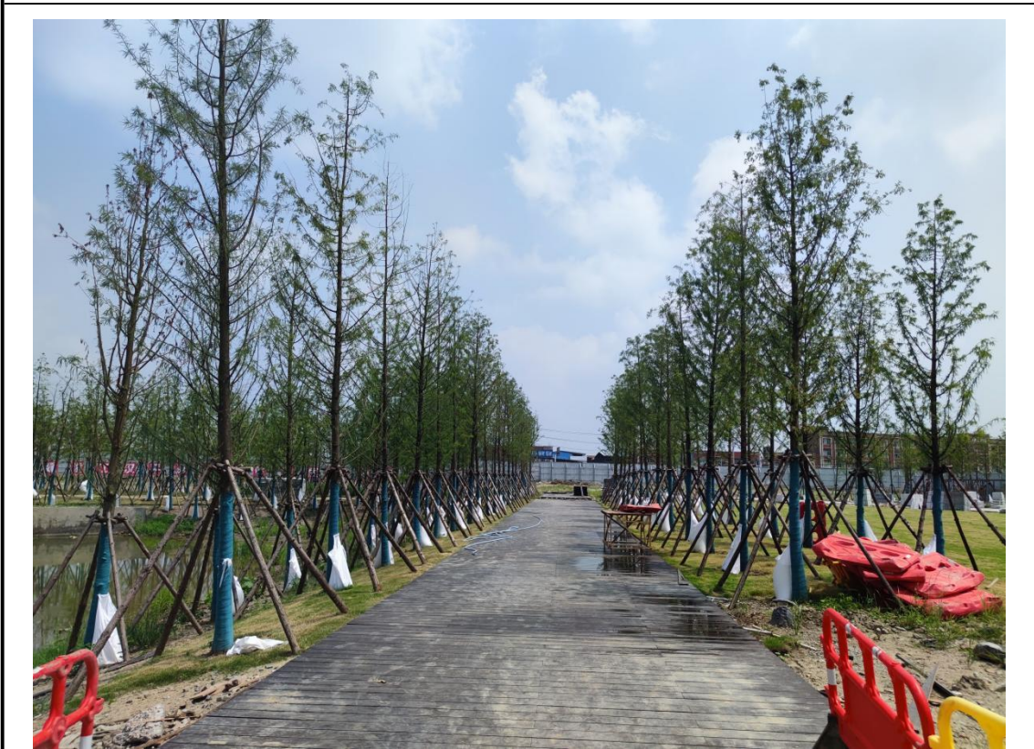
道路铺装（2023年9月）
