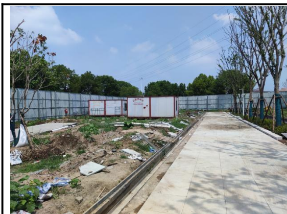
砖砌排水沟（2023年8月）
