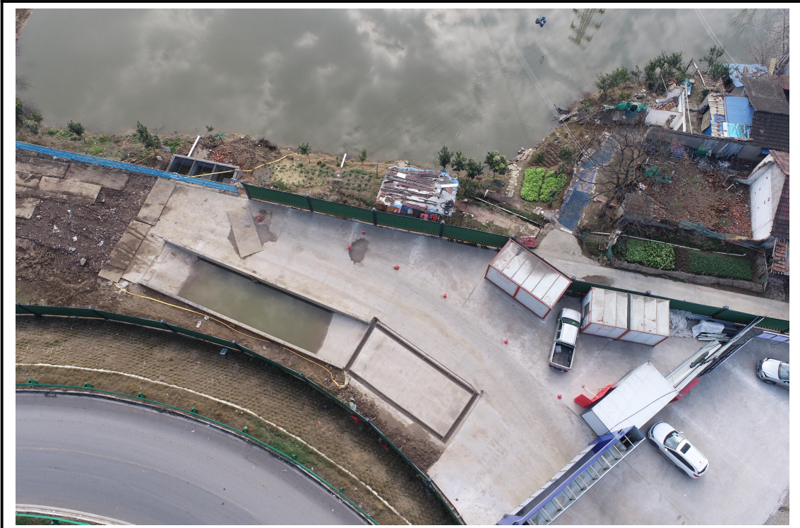
施工生产生活区（2023年12月）
