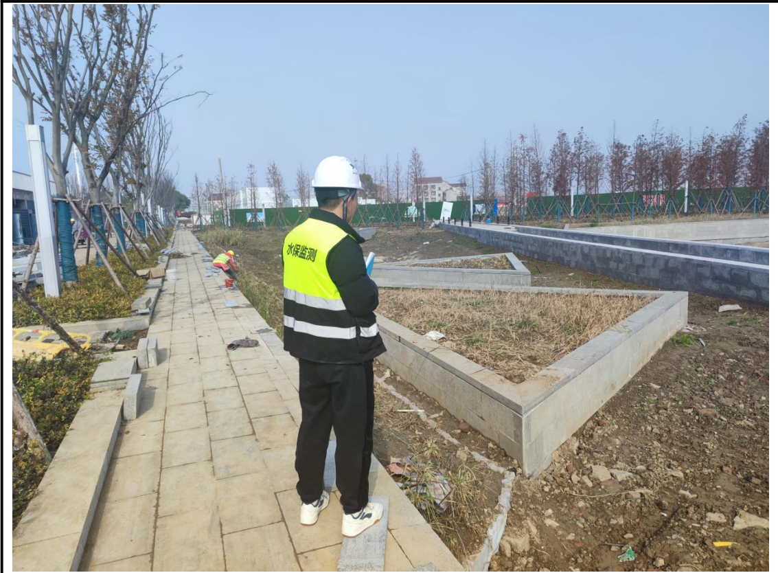
道路铺装 (2023 年 12 月)
