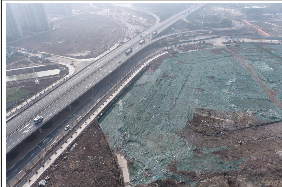
临时苫盖 (2023 年 12 月)
