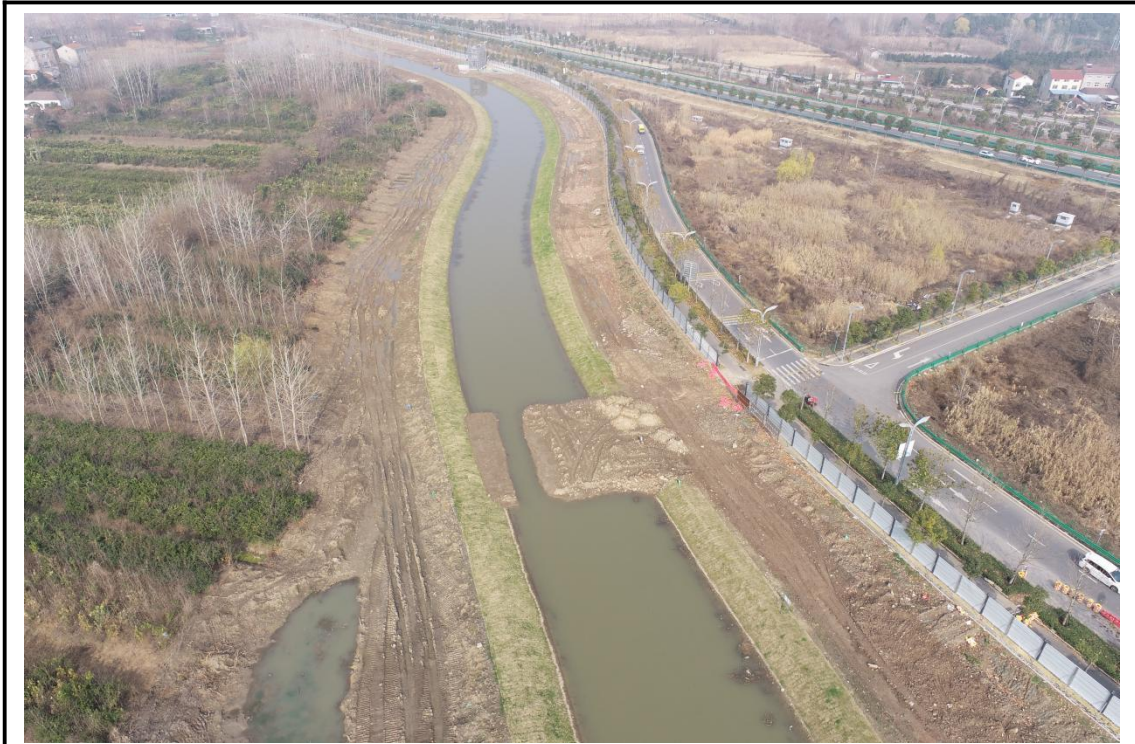
运动及水岸公园区现状（2023年12月）
