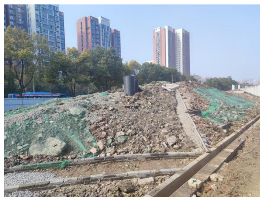
临时苫盖 (2023 年 11 月)
