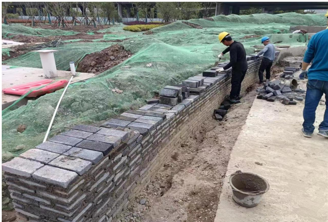
临时苫盖（2023年4月）
