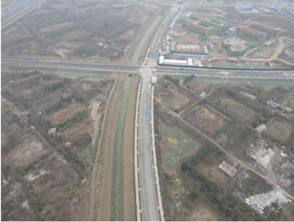
运动及水岸公园区现状（2023年6月）
