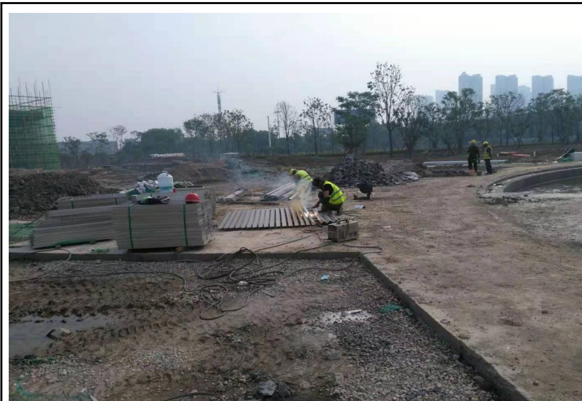
道路铺装（2023年6月）
