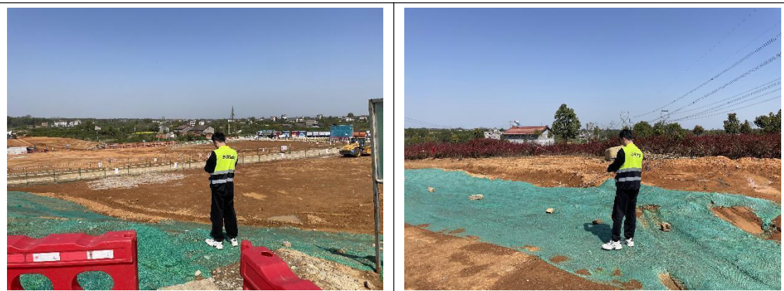
本期水土保持监测，无人机航拍
