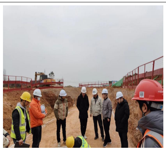
排水工程坑槽检查 (2024.1.15)
