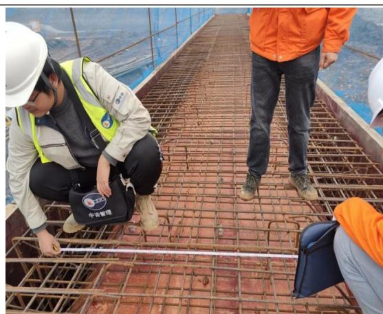
箱涵钢筋绑扎验收 (2024.1.4)
