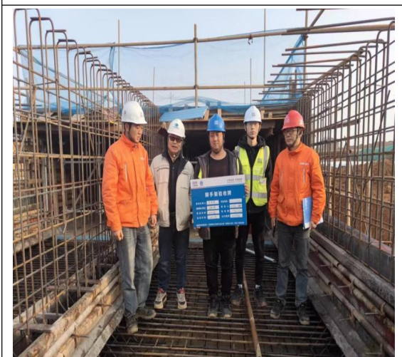
箱涵模板支架验收 (2024.1.9)
