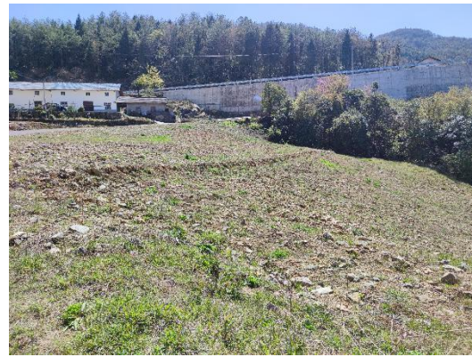
K2+281 弃渣场播撒草籽
