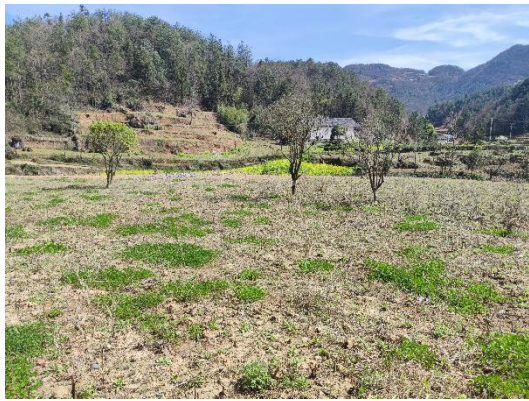
K21+580 弃渣场播撒草籽
