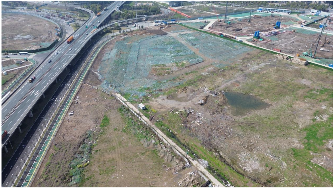
临时苫盖（2024年3月）
