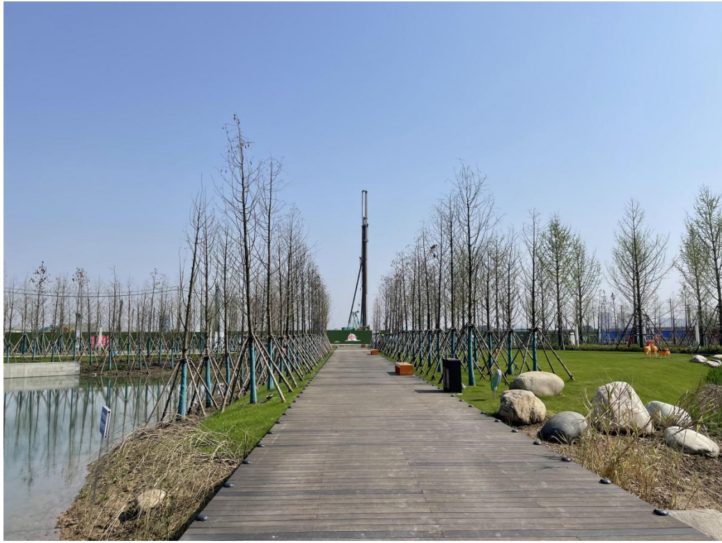
道路铺装 (2024年3月)
