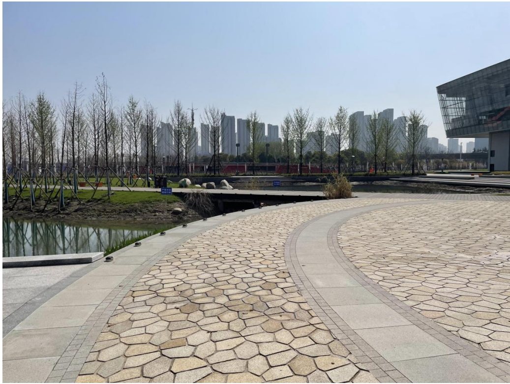
道路铺装 (2024年3月)
