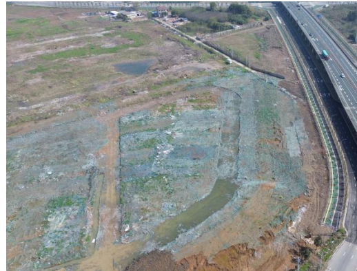
临时苫盖（2024年3月）
