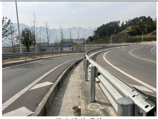
排水设施现状
