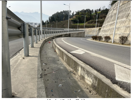
排水设施现状
