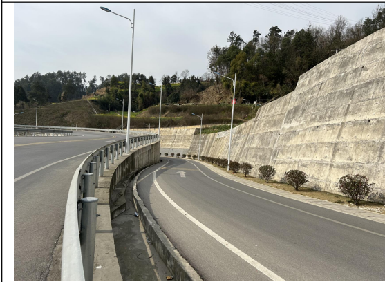
排水设施现状
