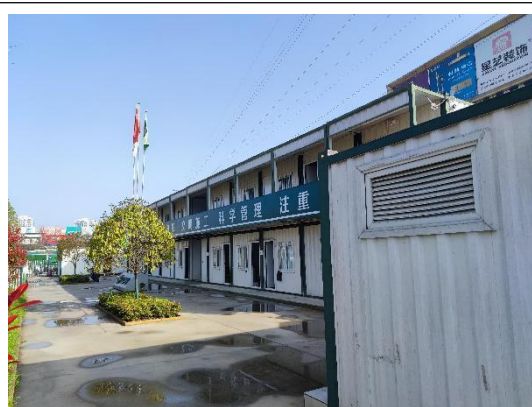
施工生产生活区
