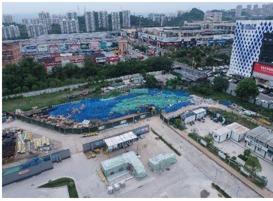
临时堆土场区
