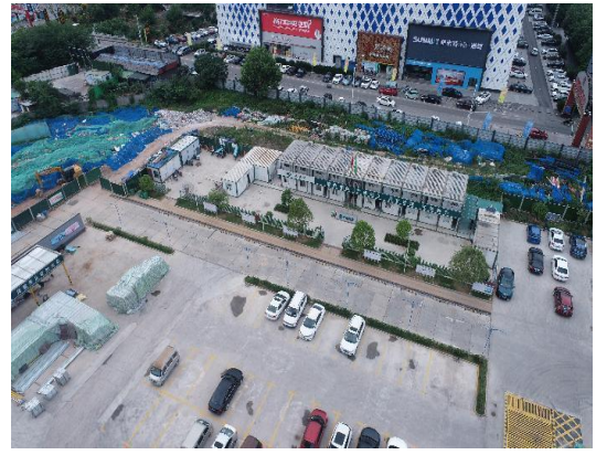
施工生产生活区
