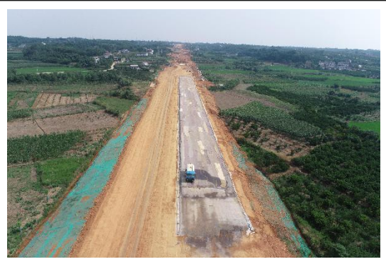
水稳垫层铺筑
