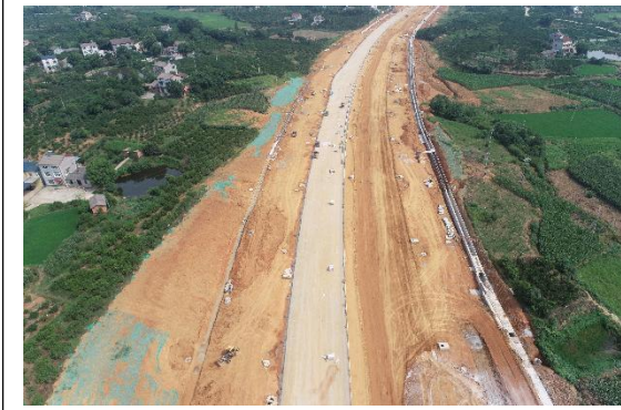
水稳垫层铺筑
