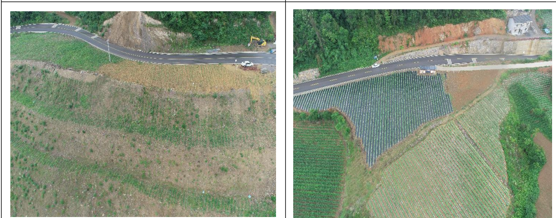
K10+140 弃渣场植被恢复情况
