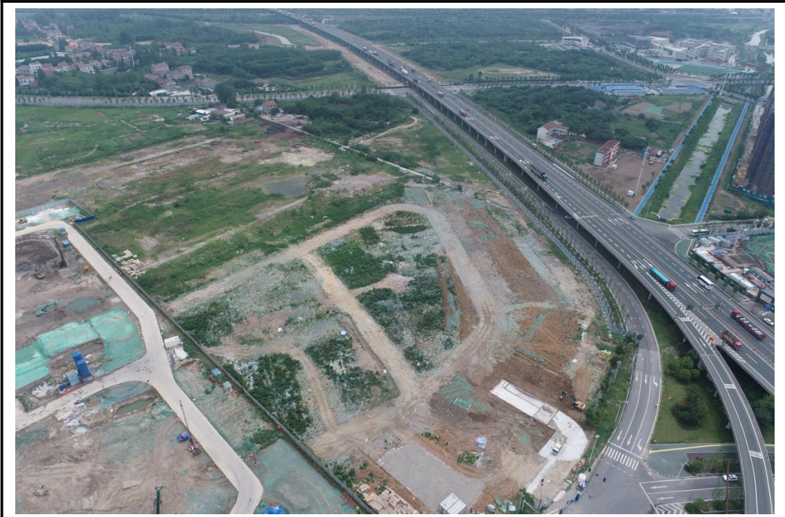
临时苫盖（2024年6月）
