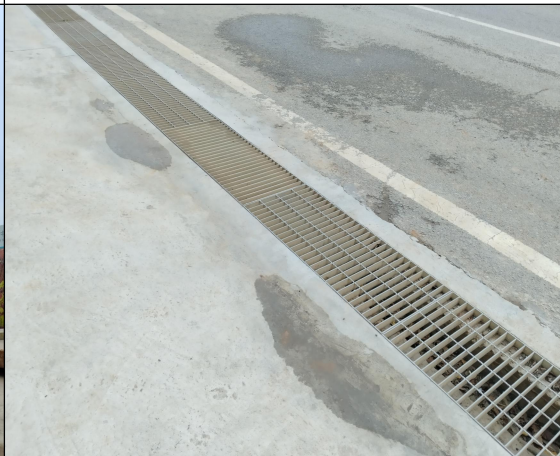
施工场地砖砌排水沟
