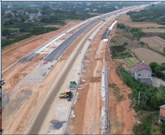
道路工程区排水沟
