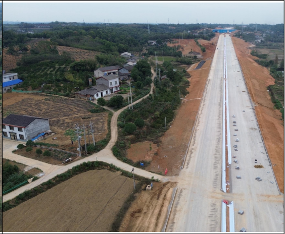
水稳垫层铺筑
