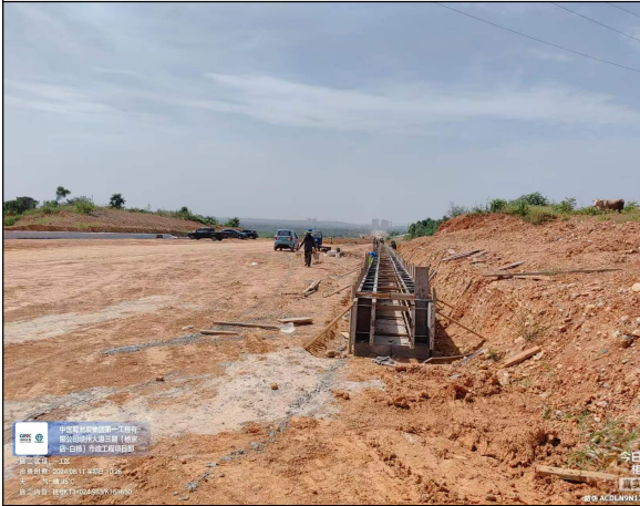
0.6m x 0.6m 排水沟 (2024.9.25)
