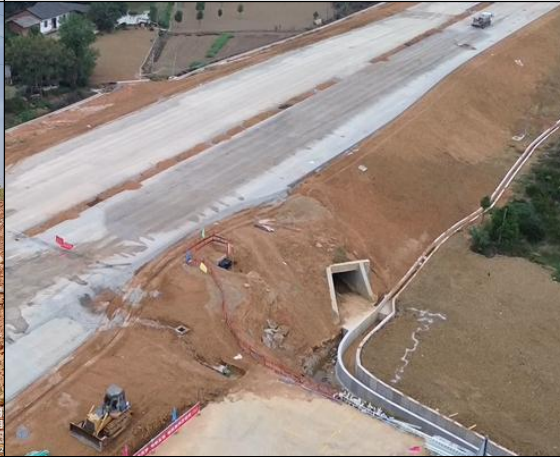
0.8m x 1.0m 排水沟 (2024.9.25)
