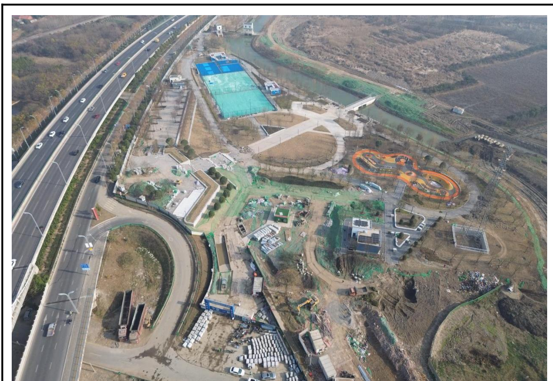
运动及水岸公园区现状（2024年12月）
