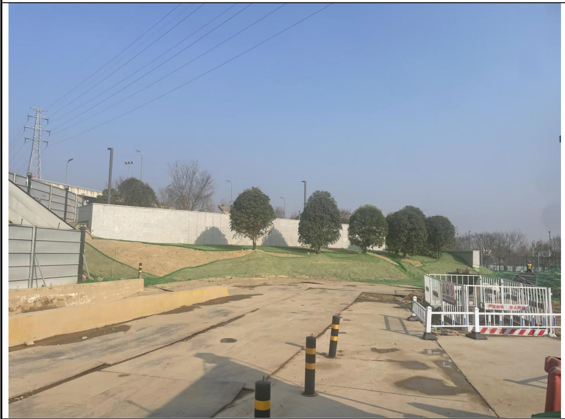
临时苫盖（2024年12月）
