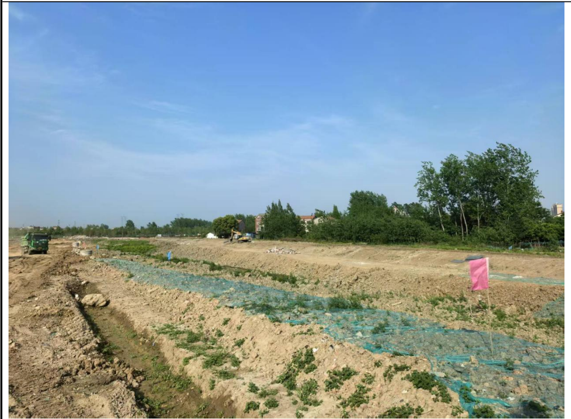
临时苫盖（2025年3月）
