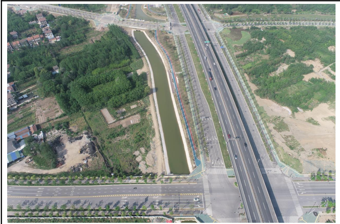
运动及水岸公园区现状（2025年3月）
