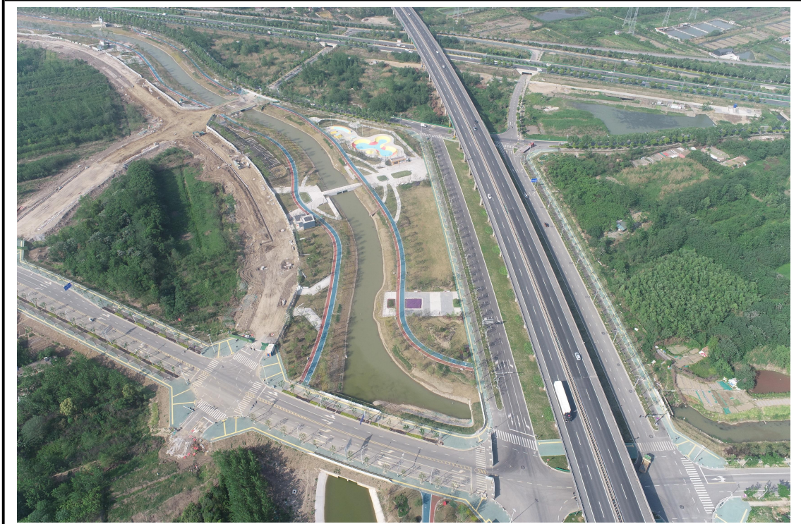
运动及水岸公园区现状（2025年3月）
