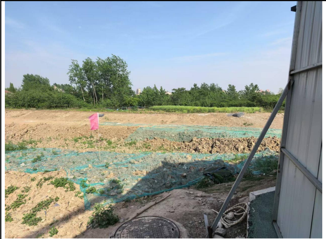
临时苫盖（2025年3月）
