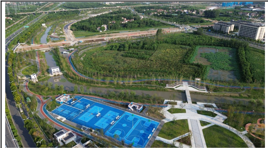
运动及水岸公园区现状（2025年6月）
