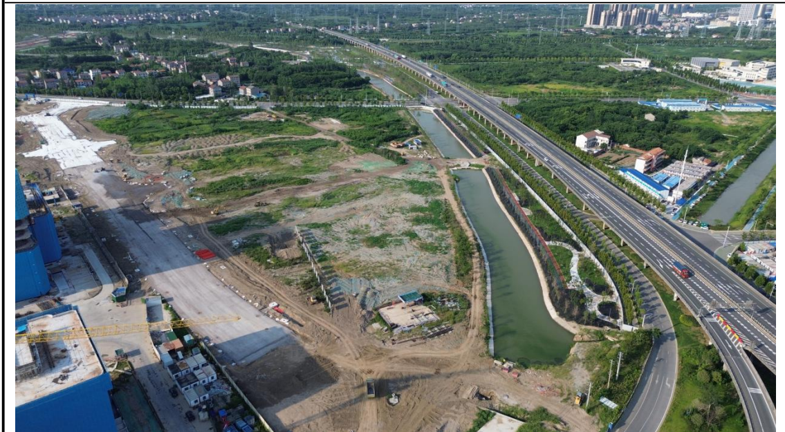
运动及水岸公园区现状（2025年6月）
