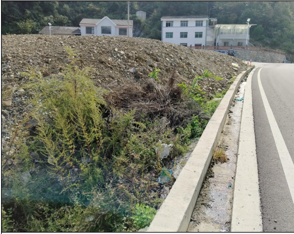
排水沟碎石待清理
