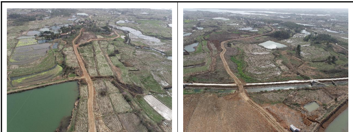
4号风机进场道路（2024年3月）
