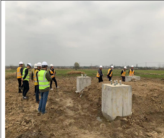
集电线路塔基施工 (2024.3.23)
