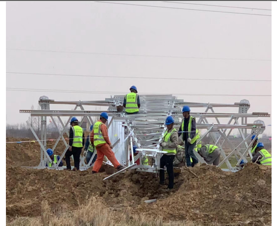
集电线路塔基施工 (2024.3.23)
