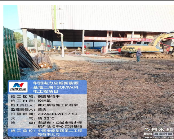
施工生产生活区 (2024.3.28)
