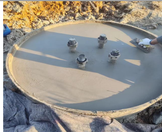
集电线路塔基施工 (2024.3.23)
